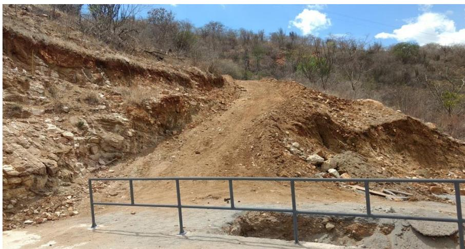
Foto 15.1: Guarda-corpo de montante da crista do muro lateral direito instalado e com pintura em primer epóxi. Posteriormente esse trecho do guarda corpo foi removido para permitir o acesso de veículos à crista.
