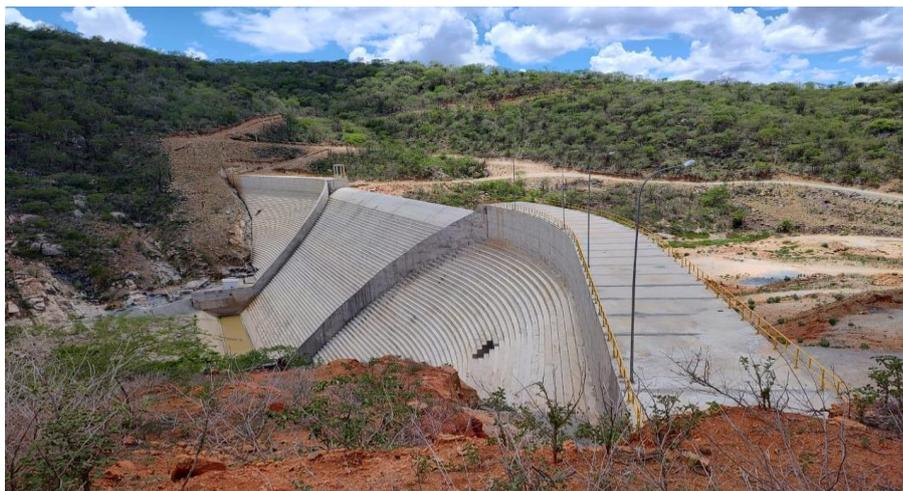
Foto 15.2: Vista geral da barragem com os guarda-corpos pintados em epóxi cor “amarelo segurança”.
