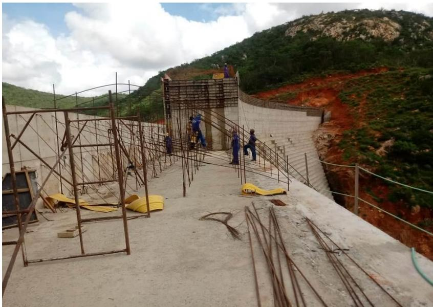
**Foto 12.4:** Vista da região de contato do extravasor com o muro lateral esquerdo durante a execução dos serviços de armação da soleira. Pode-se visualizar a fôrma necessária para execução da seção retangular no contato.
