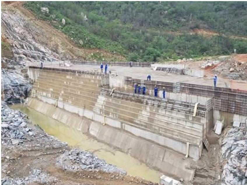
**Foto 12.3:** Vista da execução dos degraus de jusante antes da execução da bacia de dissipação e das respectivas fôrmas executadas nessa região.
