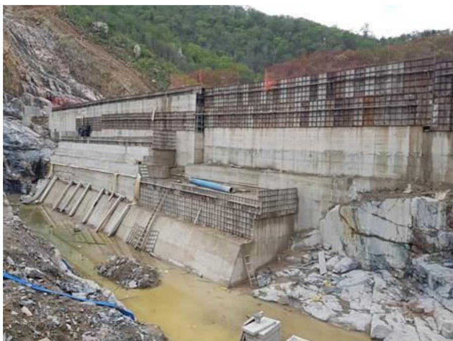
**Foto 12.1:** Vista de jusante com a elevação do maciço de CCR com paramento de jusante vertical, antes da execução da bacia de dissipação, que desencadeou na execução de fôrmas adicionais.
