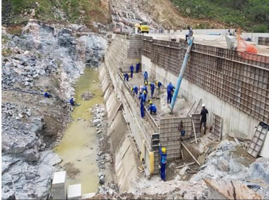
**Foto 12.2:** Vista das fôrmas para execução dos degraus nas proximidades da bacia.
